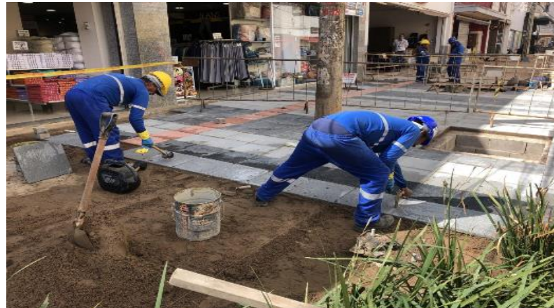
Figura 3 - SEQ Figura \* ARABIC 3 - Execução das calçadas da Rua 14 de julho no Projeto Reviva Campo Grande.
