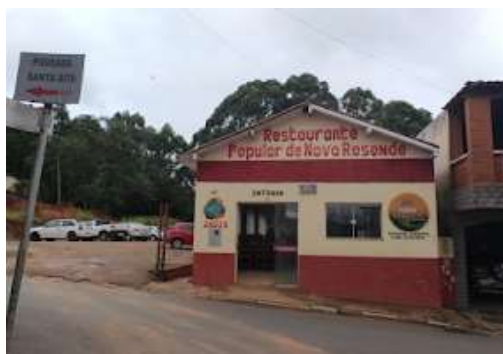
Figura 1C – Restaurante Municipal do município de Nova Resende - MG.
