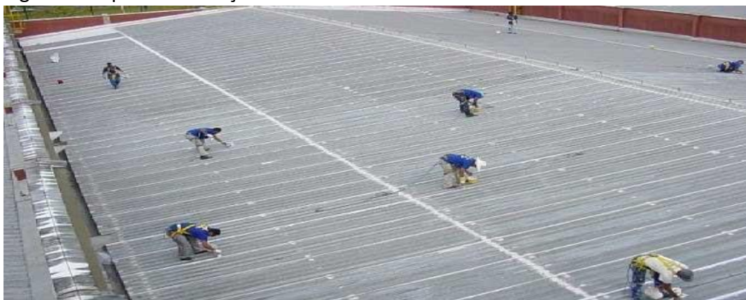
Figura 2: Impermeabilização em Telhado
