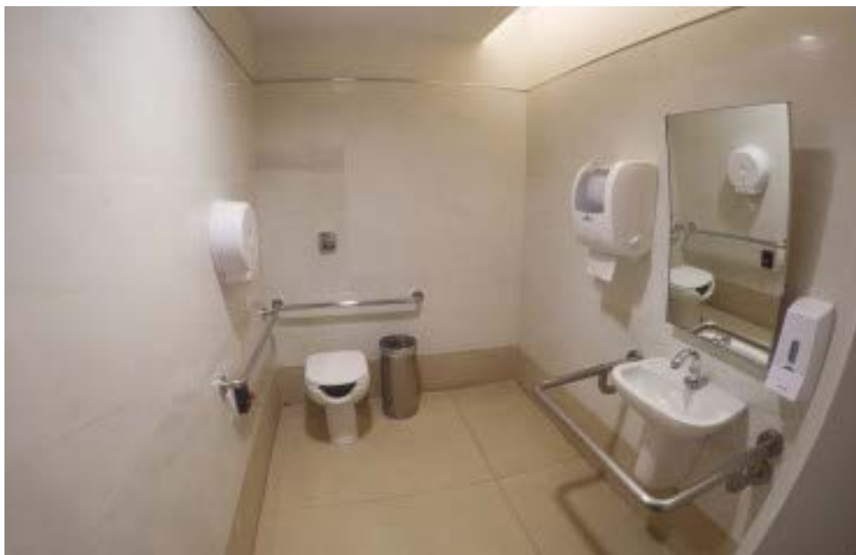
Figura 4 – Banheiro PCD no Park Shopping Campo Grande
