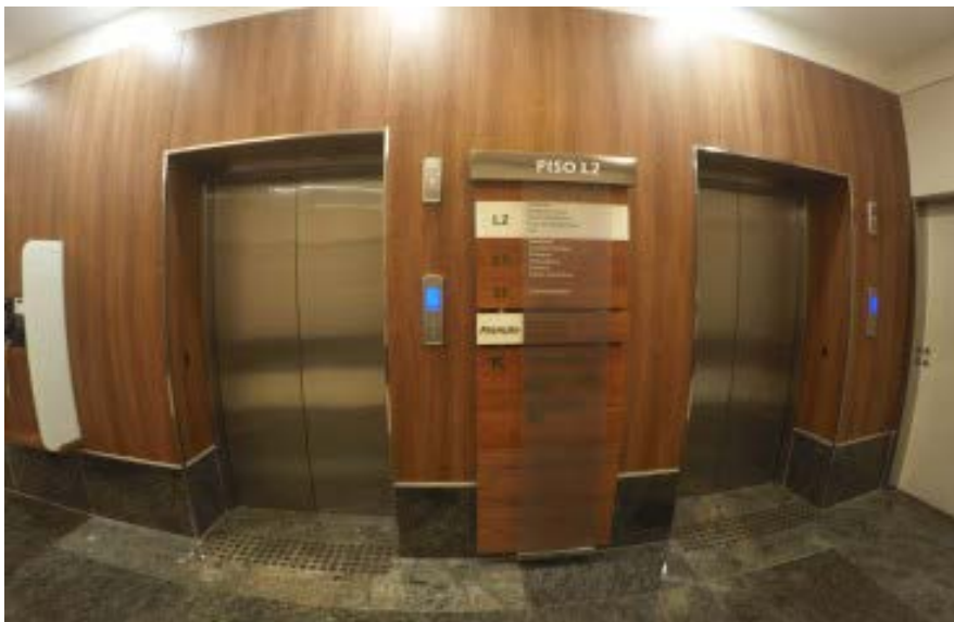
Figura 3 – Elevadores e piso tátil no Park Shopping Campo Grande
